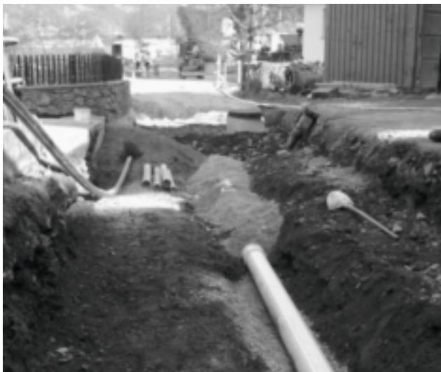
Von der Baltschanastrasse bis zum Kiesfang wurde eine neue Regenabwasserleitung erstellt. Die Strassenentwässerung wurde an diese Leitung angeschlossen, ebenso die Regenabwasserleitungen aus den privaten Liegenschaften.
