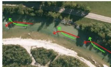
Die selbe Stelle nach dem Einbau von Lenkbuhnen. Die oberflächennahe Strömung (rot) fließt nun in Richtung Innenkurve, die sohlennahe Strömung (grün) in Richtung Außenkurve. 50 Foto: LDBV Bayern
