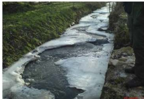
Diese von Gerd Stellmacher in Horka (Lausitz) gebaute Pendelrampe gibt einem kleinen, begradigten Bach wieder die Möglichkeit, naturnah zu mäandrieren. Im Winter ist der Effekt dieser IRT-Bauweise besonders gut zu sehen.
