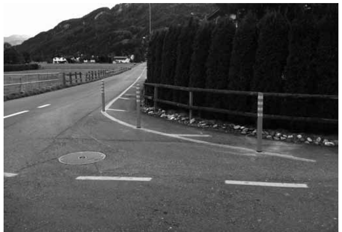
Im Rahmen der Erhebungen wurden kleine Sofortmassnahmen – hier sehen Sie den Einlenker Härtschtrasse/Ringstrasse – sofort umgesetzt.
